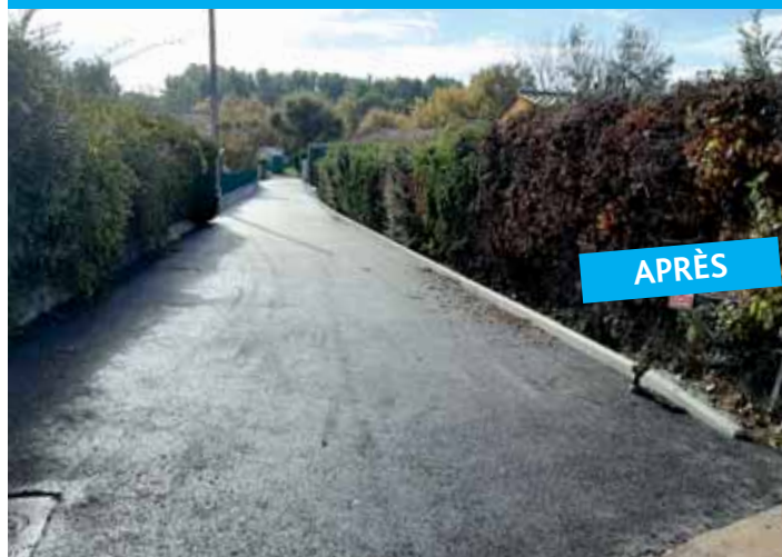
Pose d'un nouvel enrobé impasse du Vallon
