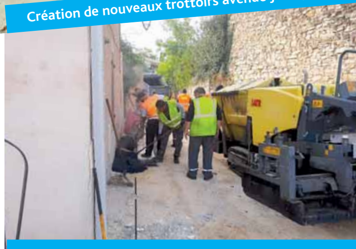
Réhabilitation des voiries et réseaux de la rue des Bergers
