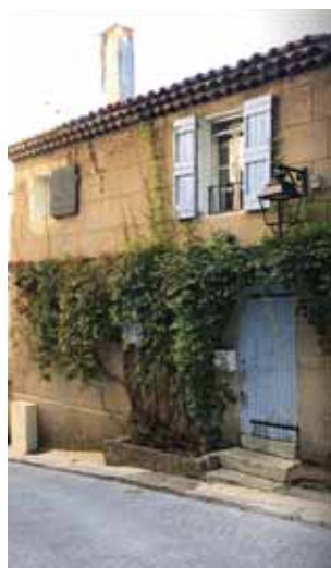
1 er Hôtel de Ville, utilisé du XIV ème siècle jusqu'en 1723, (rue de l'Eglise)
