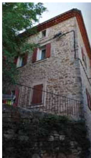
3 ème Hôtel de Ville installé à la Révolution dans le Château Vieux de l'abbaye Saint-Victor (place de l'Eglise)
