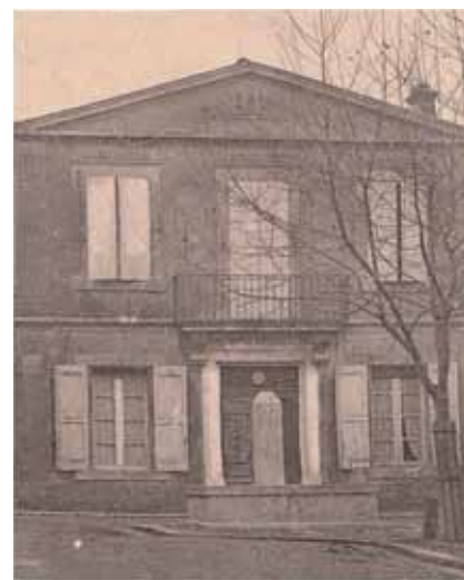
En 1833, la commune inaugure le 4 ème Hôtel de Ville, le premier véritable monument municipal de Peynier (cours A. Laurent)
