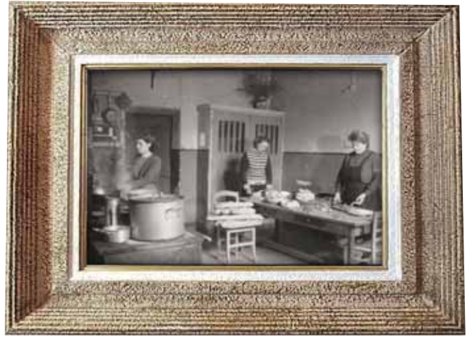
Cuisines du château du temps de l'école d'éducateurs spécialisés, milieu du XIX ème siècle. © Collection Domaine de Branguier
